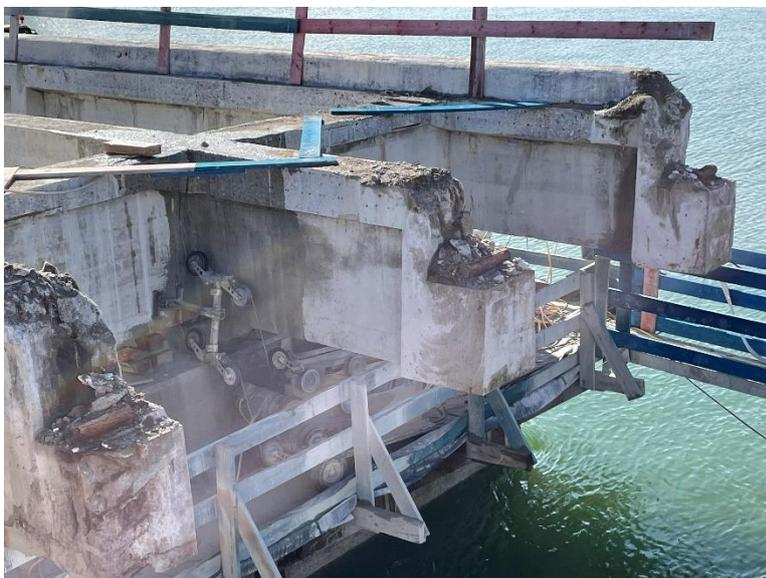
Eine Diamant-Seil-Sägemaschine zwischen dem vorderen und mittleren Träger schneidet die letzten Betonblöcke auseinander. Diese steht auf einem Gerüst, das rund um den Brückpfeiler gebaut ist.
