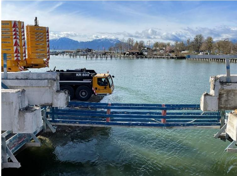
Die drei Mittelstücke der Fahrbahnträger sind bereits herausgehoben. Nur ein Holzsteg, auf dem die Bauarbeiter hin und her gehen können, verbindet die übrigen Elemente noch. Links der große Kran, der auf einer künstlichen aufgeschütteten Insel in der Alz steht. Im Hintergrund der Segelhafen mit dem Regatta-Haus des SRV.
